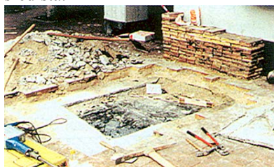
Slika 4. Ispitivanje brtvenog sloja ispod teških obloga zaštitnog betona
