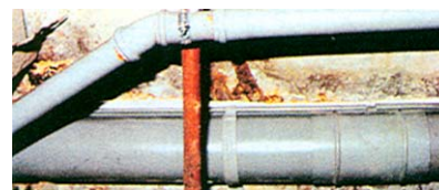
Slika 8. Cijev za skupljanje prodrle vode u ovješnim stropovima ispod rampe
